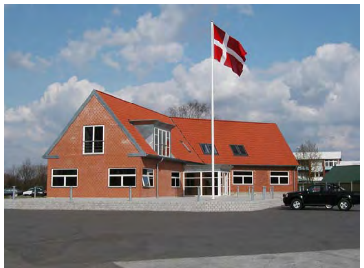
Den nyopførte administrationsbygning
