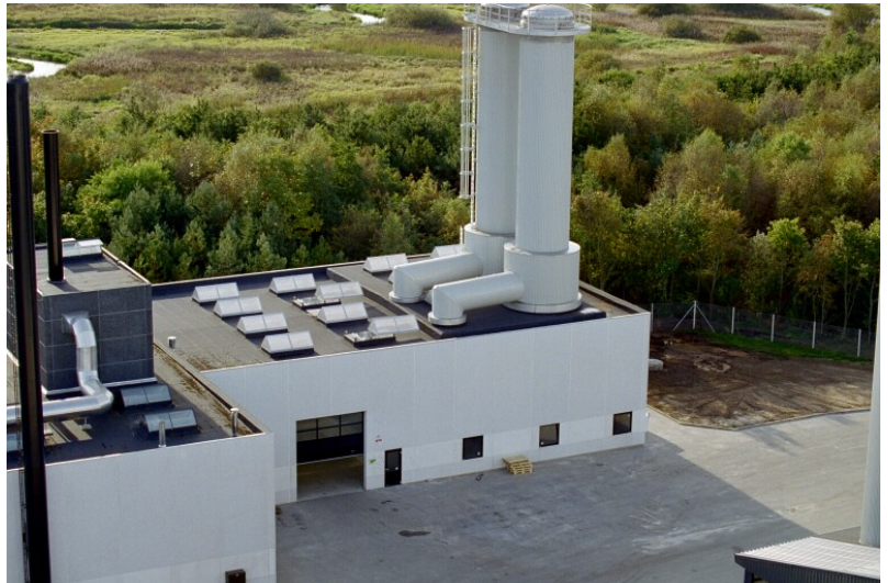
Den nyopførte inddampningsfabrik
